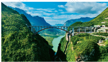
图片说明：纳雍至晴隆高速公路乌蒙山大桥
